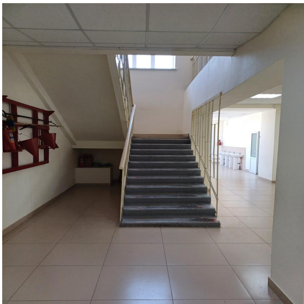
Фото 9. Лестница (внутри здания)
