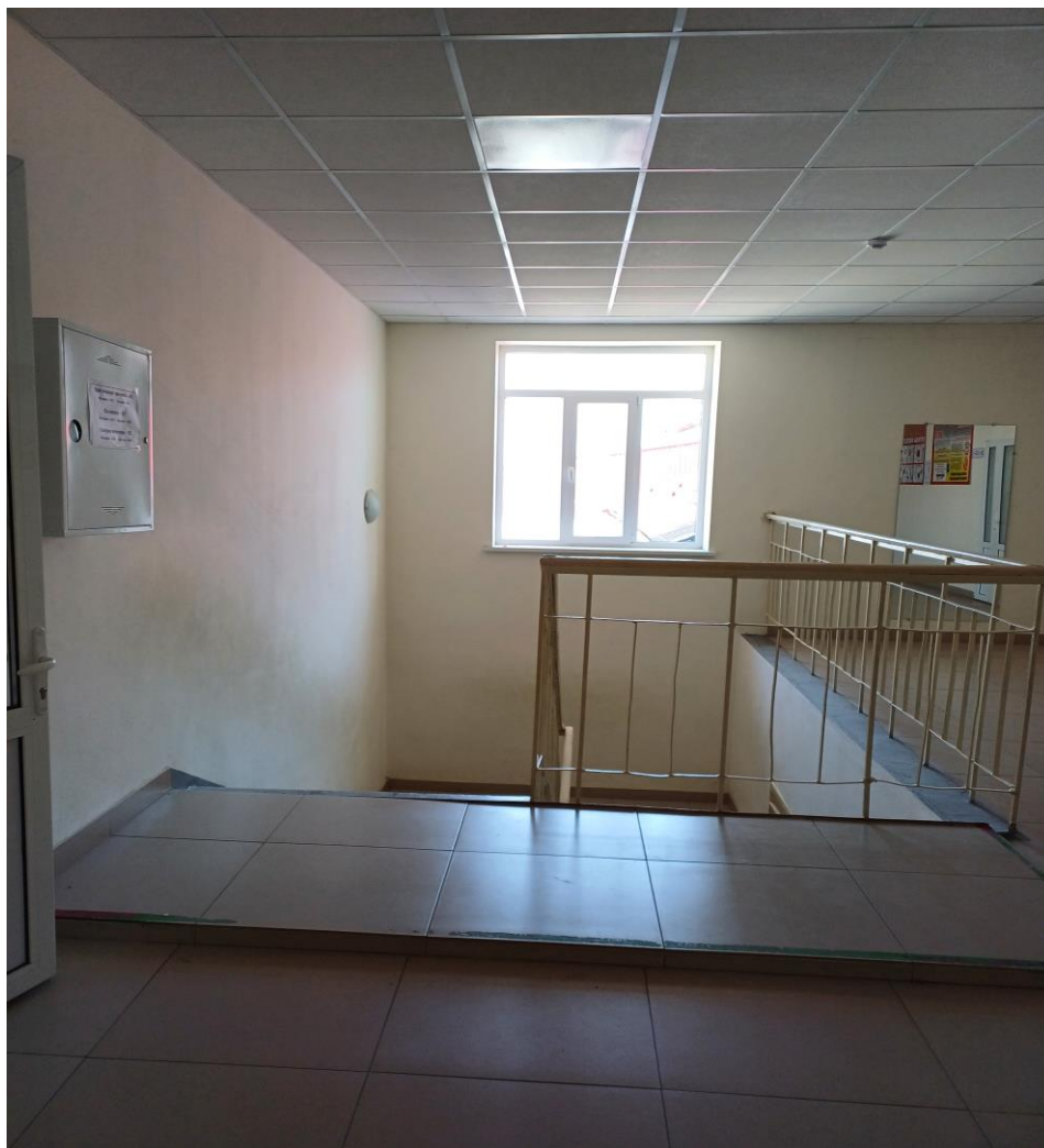
Фото 10. Лестница (внутри здания)
